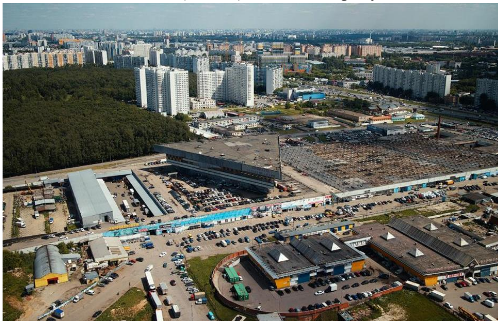
Рис. 2. Вид анализируемой территории со зданием Станции Технического Обслуживания Автомобилей (СТОА) с дрона
